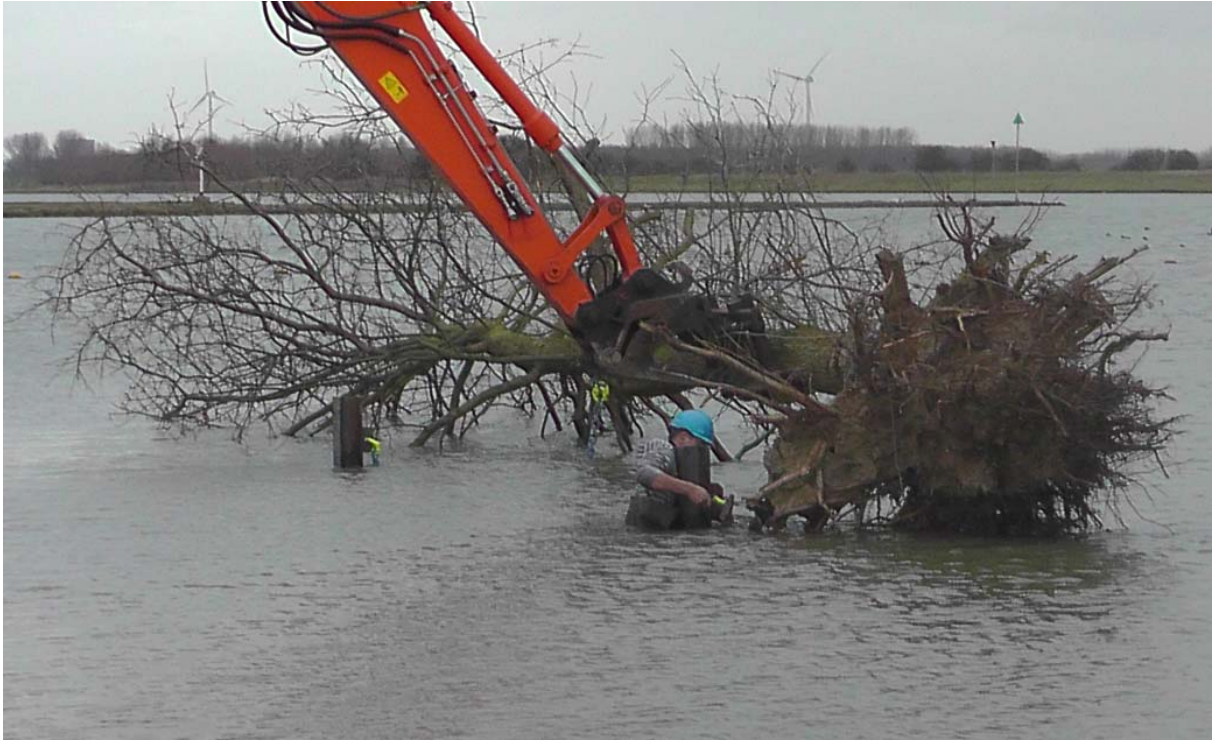
Verankering van een boom in de Lek bij Everdingen (jan. 2014)
