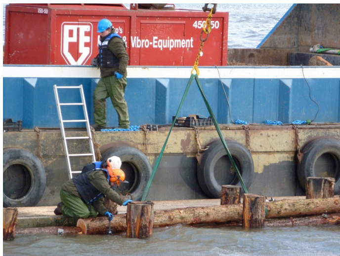
Foto 1.2 Aanbrengen van de stammen in de riviercorrigerende constructie in de Redichemse waard.
