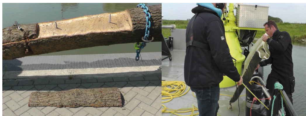
Foto 2.1 Links: een demontabel stuk van de stam wordt op de boom geschroefd voor de tewaterlating. Een duiker brengt in een net een demontabel stuk stam naar boven. (foto's: A. Klink)
