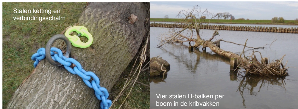
Foto 1.1: Voorbeelden van bevestigingsmethoden in de pilot rivierhout.
