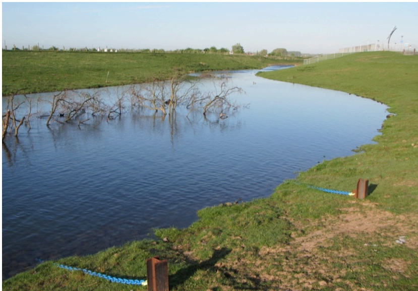
Foto 1.4 Op de oever verankerde boom in de vispassage van Stuw Amerongen, Nederrijn, Maurik ( januari 2014).
