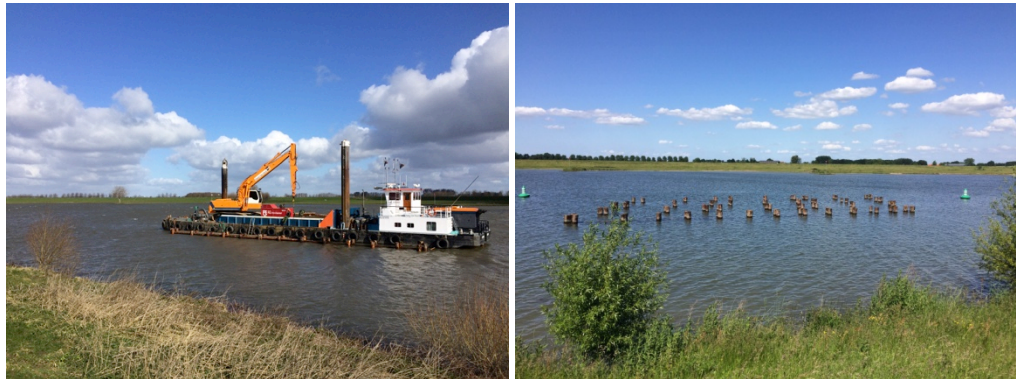
Foto 1.6 Aanleg van de bomenschermen in de Redichemse waard.
