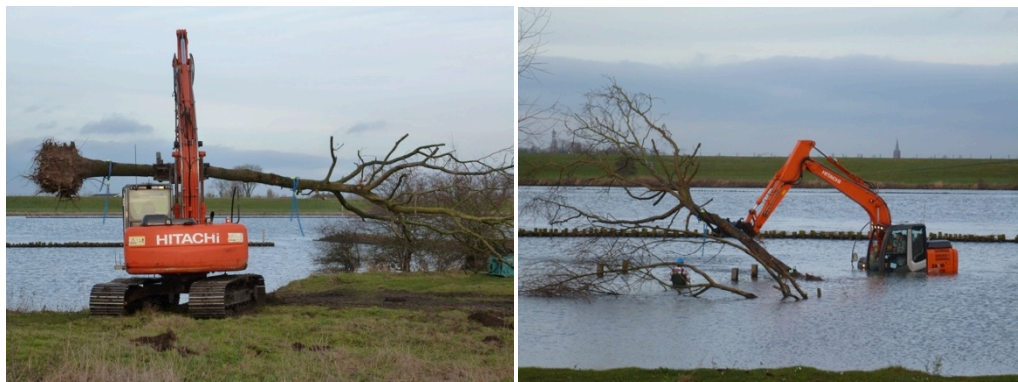
Foto 1.3 Het aanbrengen van bomen in een kribvak langs de Lek nabij Everdingen in januari 2014.
